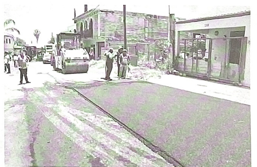
Los trabajos de repavimentación van muy avanzados.
